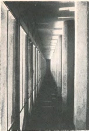
8. Restaurante del Parque en Barcelona: Doménech y Montaner: Edificio formado por doble fachada, como una caja contenida en otra caja mayor. El espacio que queda entre ambas permite un contacto más complejo entre exterior e interior. En la fotografía puede verse este espacio: al abrir huecos en la caja interior y en la exterior se obtienen complejos efectos de luz.
