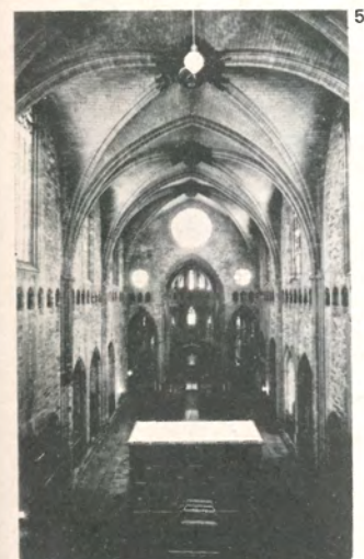
5-6. Catedral de Girona: Iglesia de nave única pero donde los espacios entre contrafuertes (que en el gótico francés son exteriores a la fachada) quedan integrados al interior formando pequeñas capillas.
