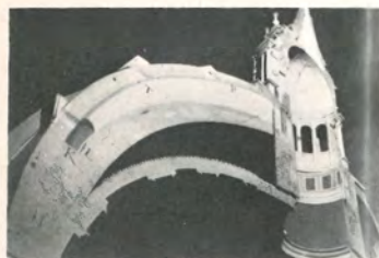
11-12. Maqueta de la cúpula de San Pedro de Roma. Miguel Ángel: En este caso, aunque existen dos cúpulas que responden a dos intenciones distintas para el exterior y para el interior, no se aprovecha aún, arquitectónicamente, el espacio intermedio.
